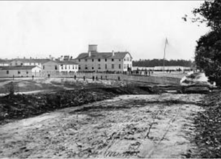
Hospital de Mount Pleasant cerca de la calle 14 y Park Rd.
